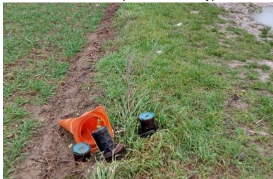
Emergences visibles au droit du chemin
